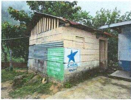
Foto 3: 2. ESTRUCTURA DE TECHO
