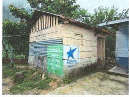
Foto 2: 1. CUBIERTA DE LÁMINA EN COCINA
