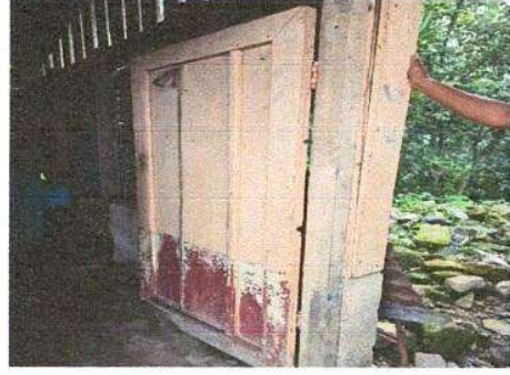
Foto 4: 4.3. PUERTA DE MADERA POR PUERTA DE METAL, EN COCINA
